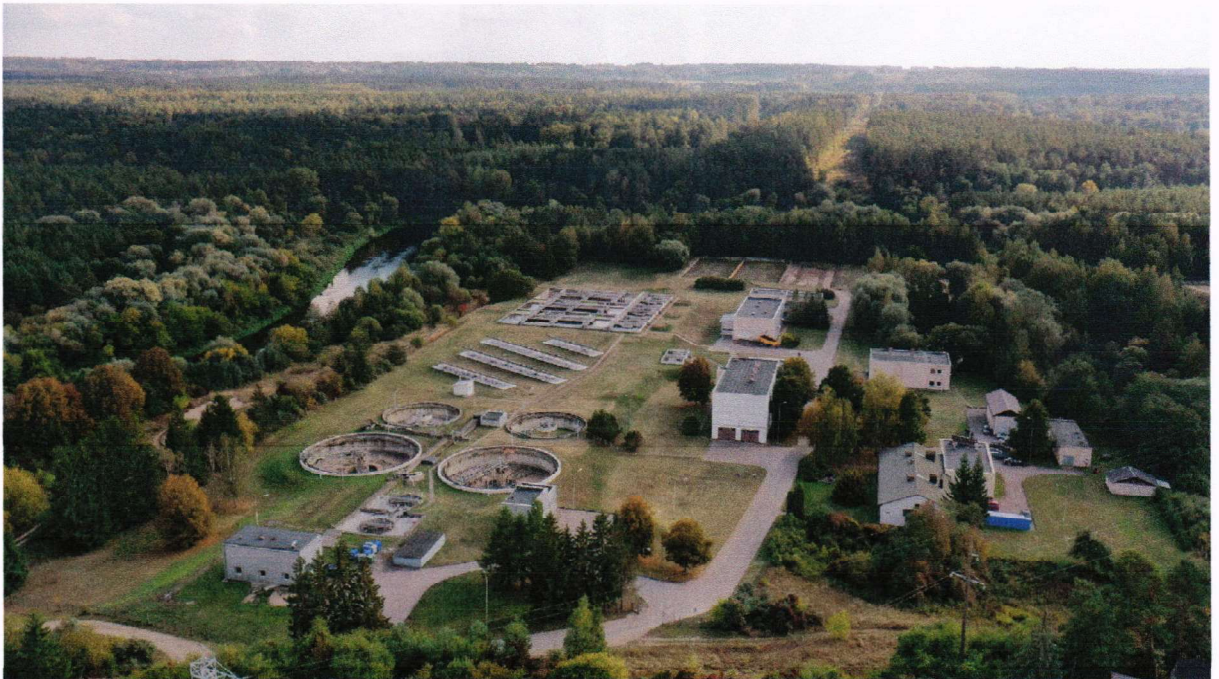
1.2.1 pav. UAB „Ukmergės vandenys“ nuotekų valymo įrenginiai
